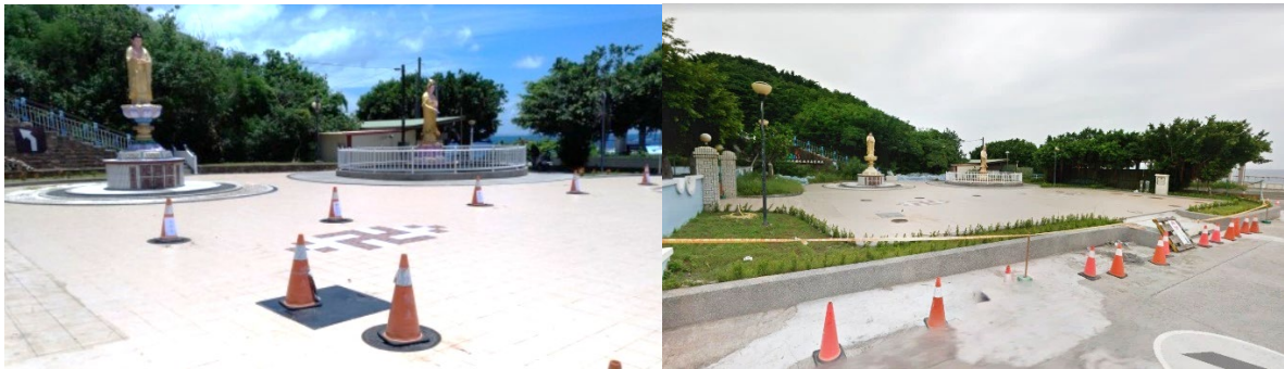
圖 13 屏東小琉球聚落污水處理系統現況，上方為廣場鋪面覆蓋，搭配部分綠化。
