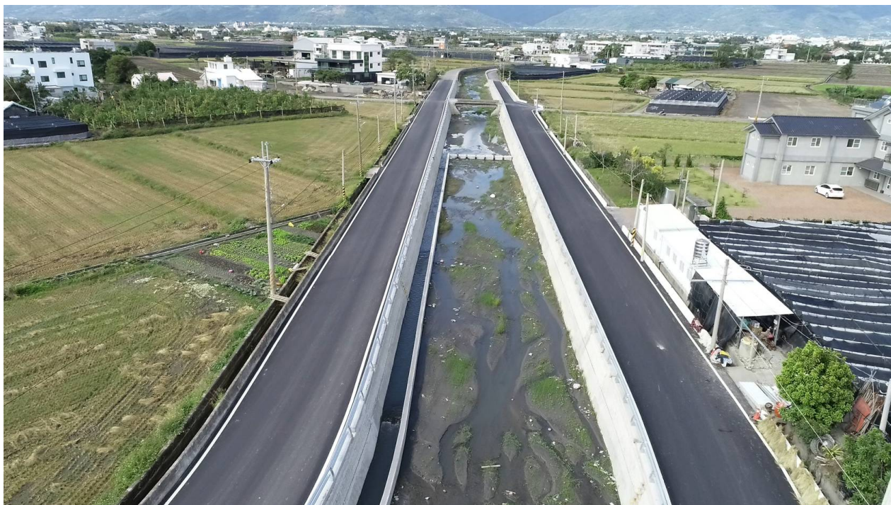
【施工完成照片】
