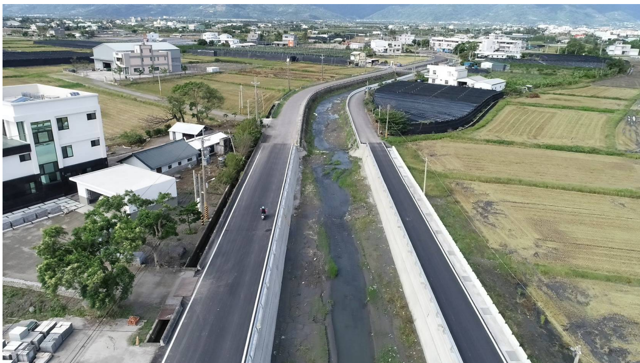
【施工完成照片】
