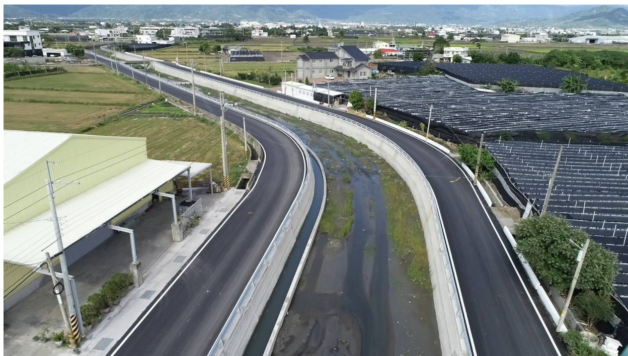
【施工完成照片】
