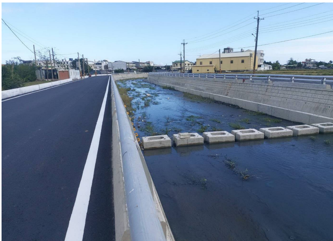
【施工完成照片】
