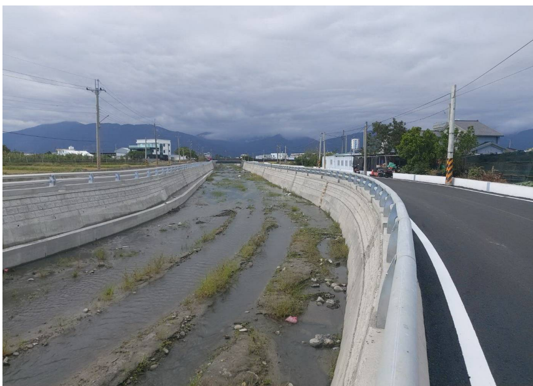
【施工完成照片】
