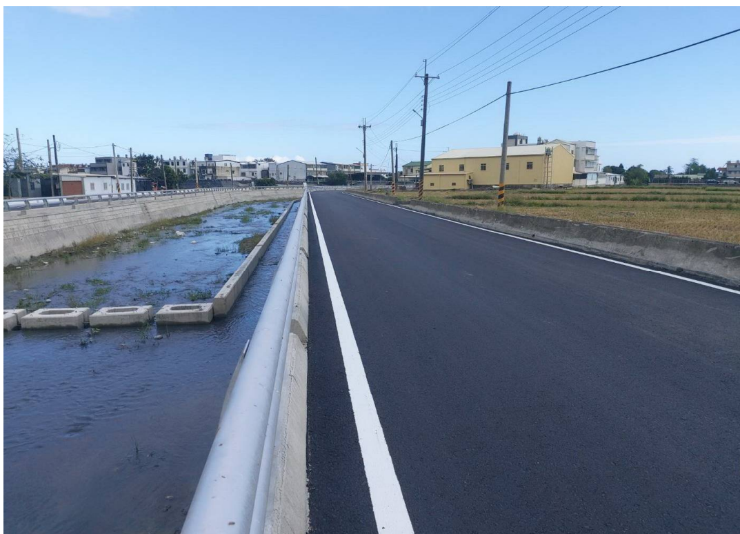
【施工完成照片】
