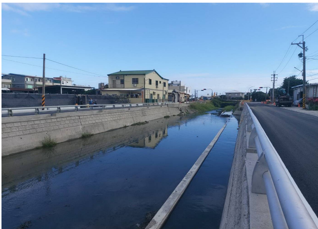
【施工完成照片】
