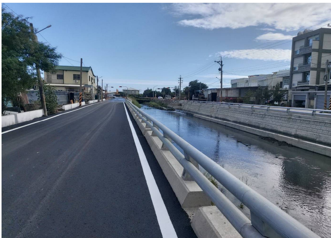
【施工完成照片】
