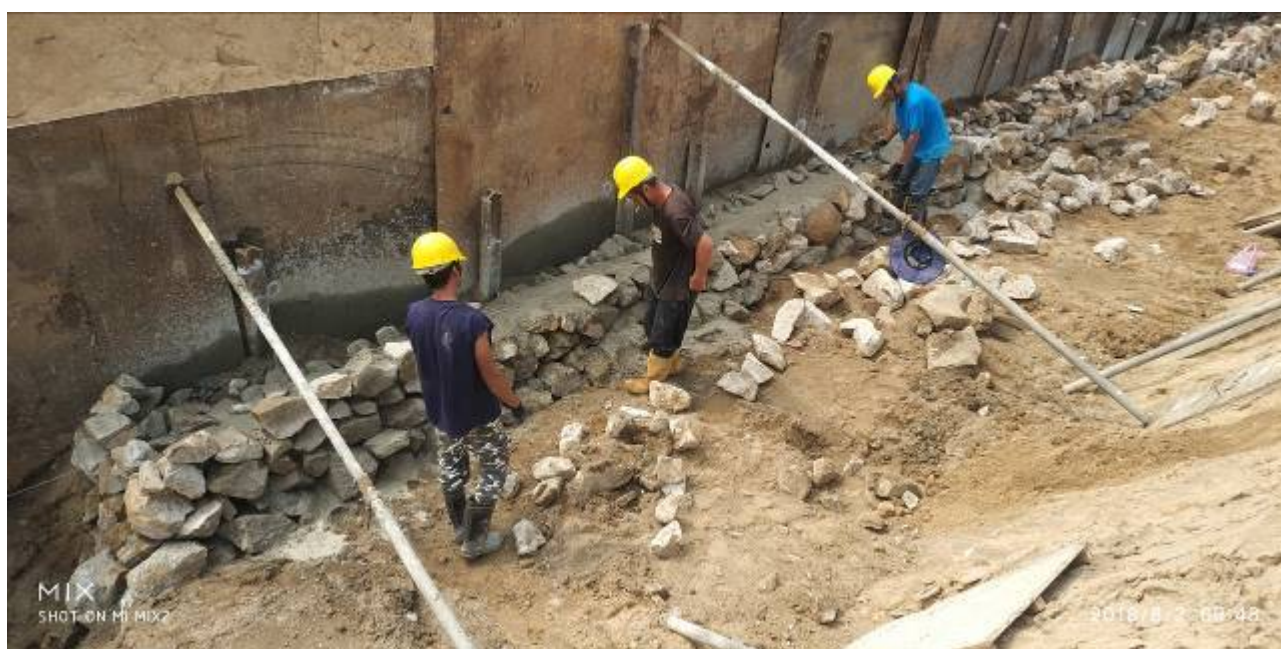
<漿砌石護岸堆砌>
