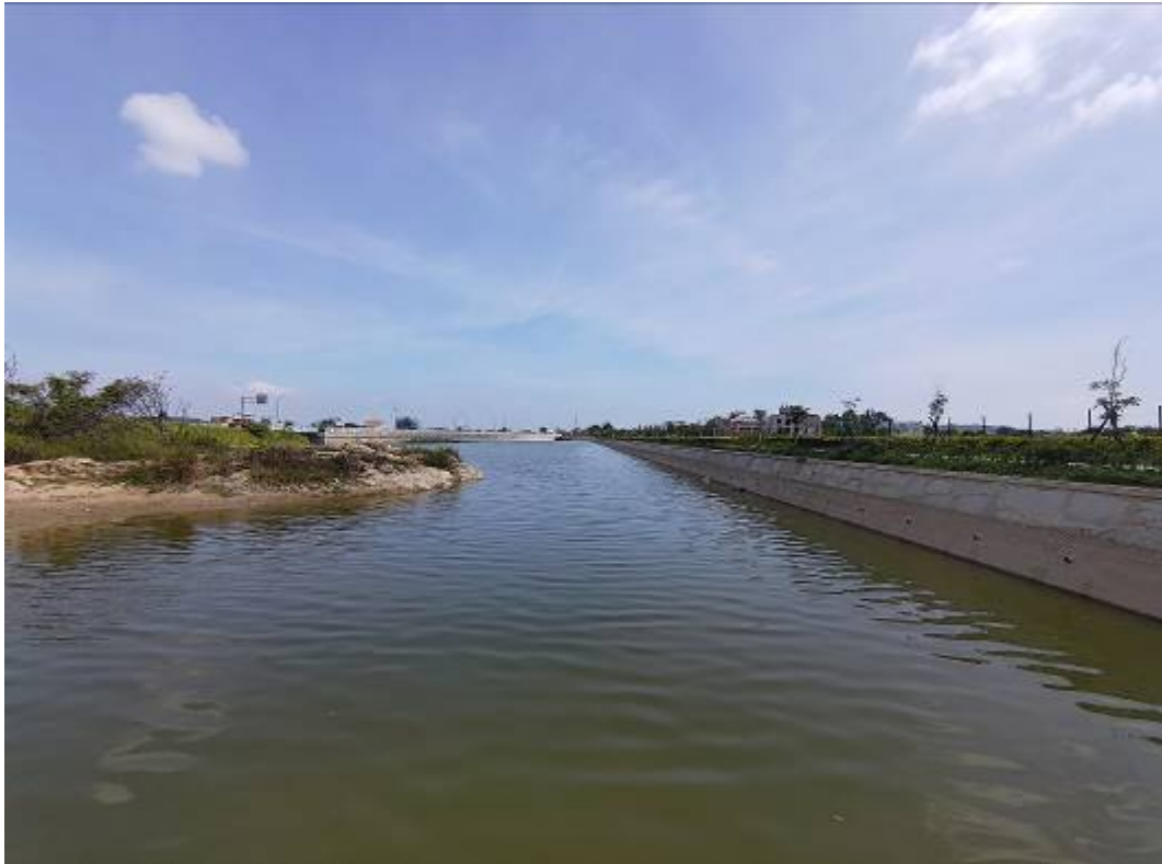
<疏濬清淤後河道蓄水狀況>
