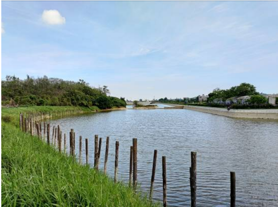
<疏濬清淤後河道蓄水狀況>
