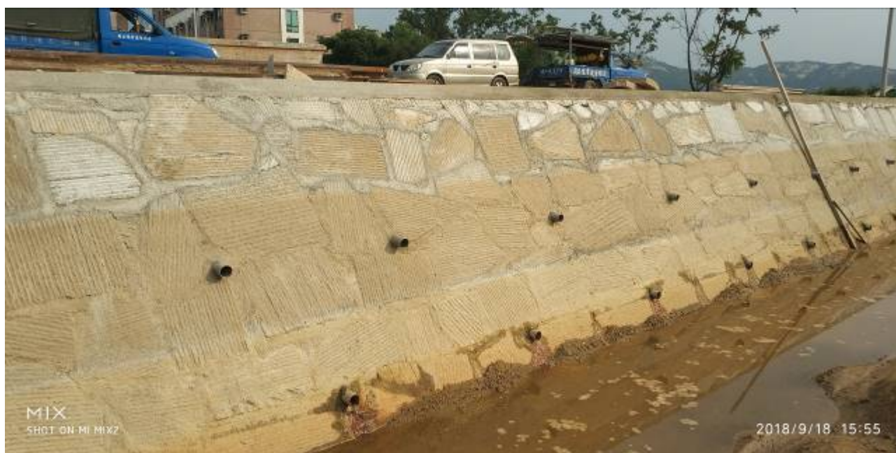
<漿砌石護岸堆砌>
