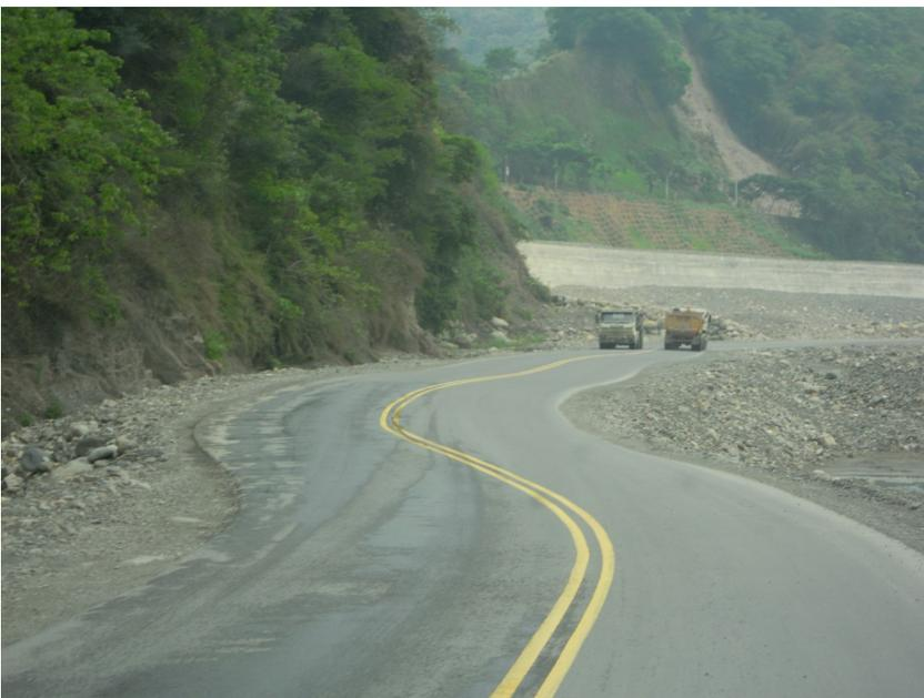
施設 AC 河床便道以加速疏濬速度，並減少空氣拋填塊石施設完成相片左圖為施設於清水溪河防構造物坡腳
