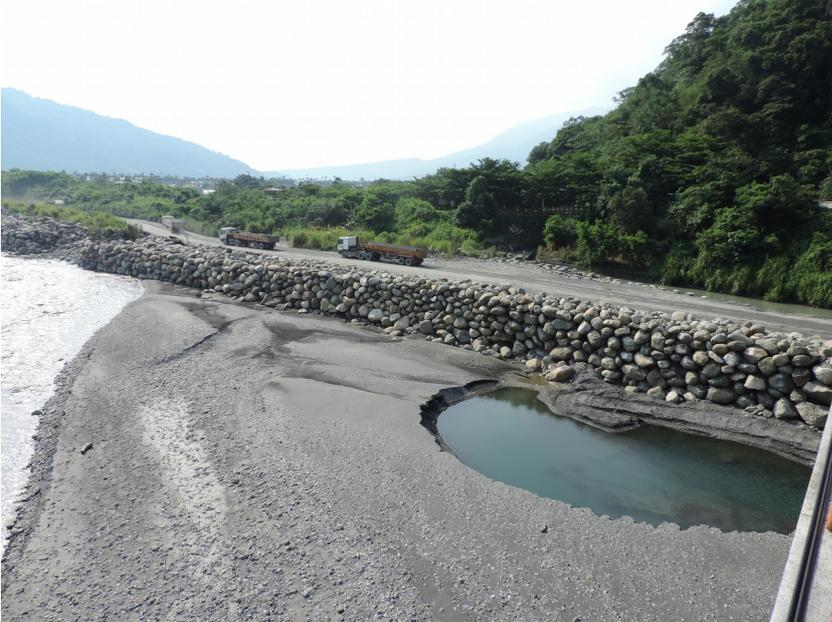
河床便道前拋填大塊石，除保護河床便道外，更可作為河防安全第一道拋填塊石施設完成相片左圖為施設於濁水溪河床運輸便道坡腳
