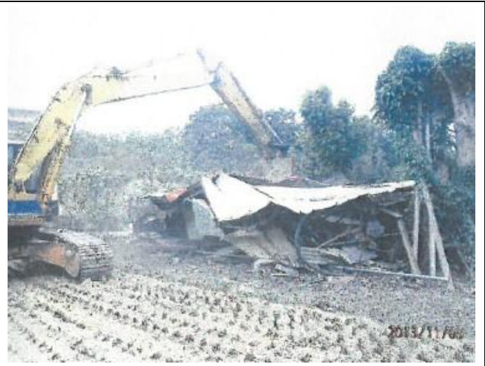
4-違章建築猜拆除施工中
