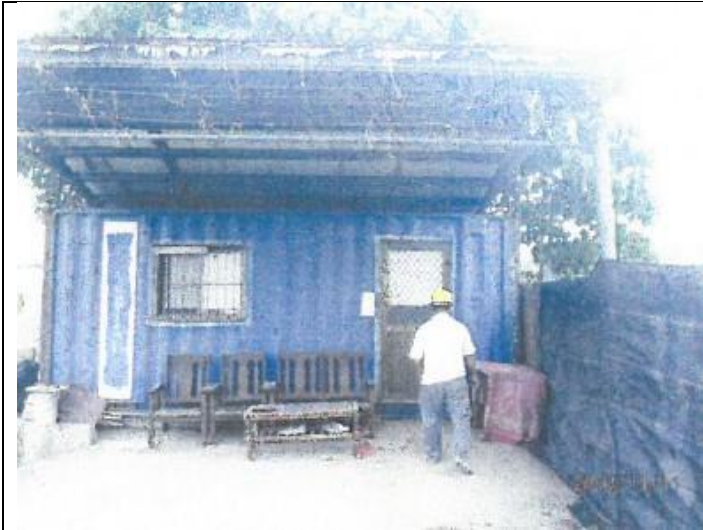
3-違章建築猜拆除施工中
