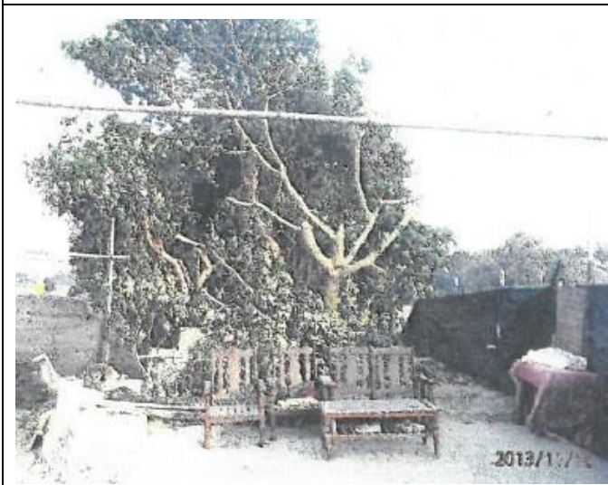
5-違章建築猜拆除施工後
