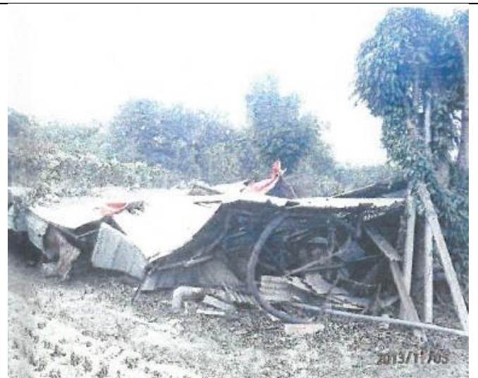
6-違章建築猜拆除施工後
