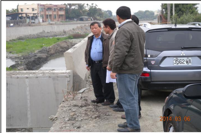
3-員林大排整治水利署王副署長工地視察聽取施工簡報
