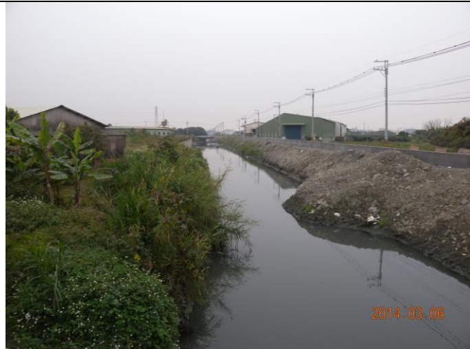
5-員林大排整治前現況照片
