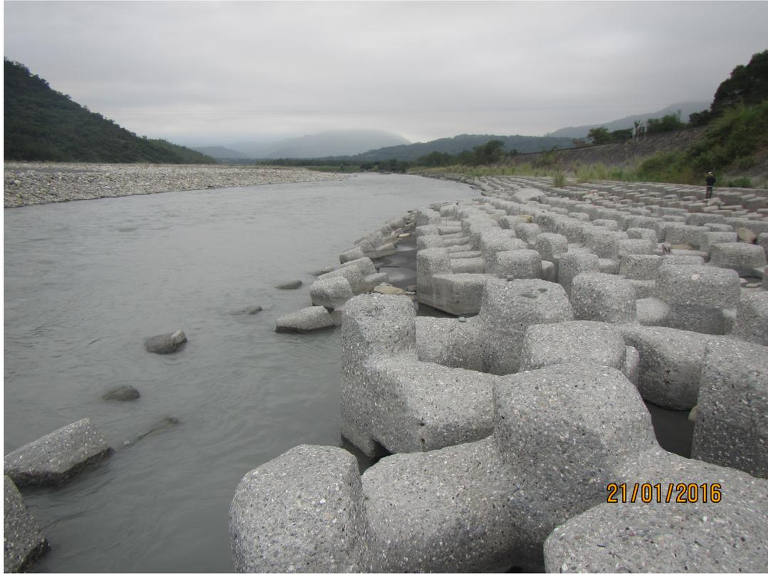
新良護岸舊有護坦工已沉陷損毀
